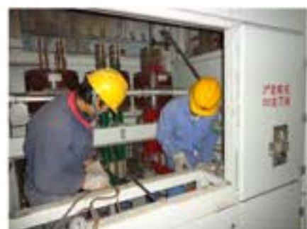
▲ 两名专业员工正在更换主刀闸
